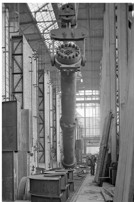
Abb. 2: Bau des Ammoniak-Reaktors 1913 Oppau. 6
